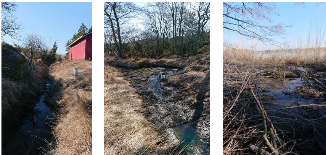
Figur 22. Utloppsdiket vid Karlby reningsverk. Sträcker sig drygt 100 meter från verket innan det övergår till ett rör som löper under åkermark där vall odlas. Diket är rakt i sin karaktär utan växtlighet (vänster) och har just innan utloppet en urgröpfung för att sakta ned flödet (mitten). Sista utloppspunkten är i strandlinjen till en invik (höger) i form av röret som går under åkern. Detta rör saknar infiltrations möjlighet. Källa: Lotta Eriksson, 2019
