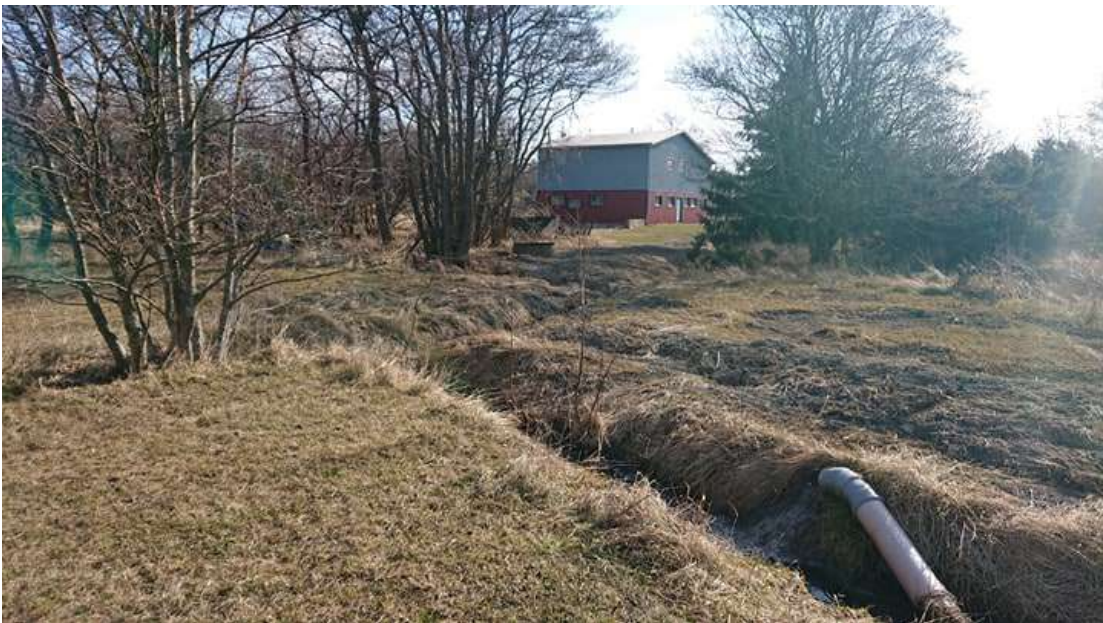
Figur 24. Diket vid Hellsö reningsverk där det någon gång under mars - april 2019 läckte ut orenat avloppsvatten. Hur mycket och hur länge det läckte är okänt. Jorden är kontaminerad och räknas som farligt avfall varpå det måste grävas bort och läggas på deponin. Lyckligtvis fanns det inte några dricksvattenbrunnar närheten. Källa: Lotta Eriksson, 2019
