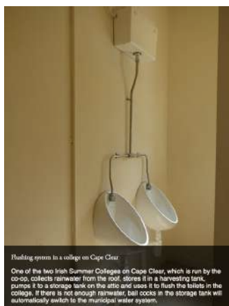
Figur 25. Regnvattenspolade urinoarer i skola på Cape Clear https://www.watersa-vingislands.com/projects
