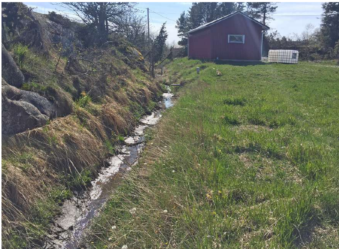
Figur 31. Utloppsdiket från Karlby reningsverk
