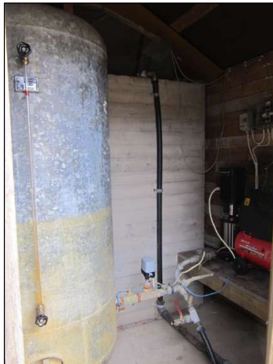
Figur 12. Den vänstra bilden visar Norråkers Vattenbolags pumphus utanför daghemmet Milan. Den högra bilden visar insidan på pumphuset, med hydroforen till vänster i bild och vattencisternen bakom planket.
