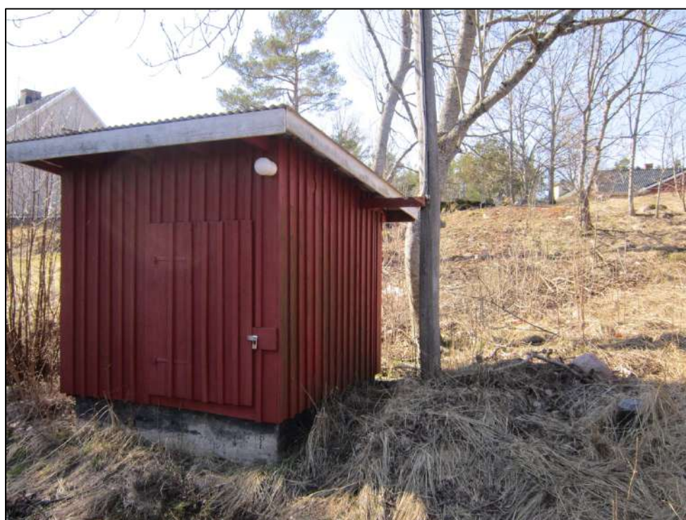
Figur 9. Torsholma Vattenbolags pumphus som ligger intill Munkviksvägen. Till höger i bilden kan det grå locket och en del av röret på det nya brunnshålet ses sticka upp ur gräset.
